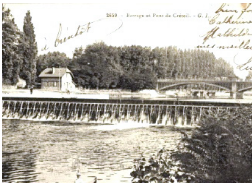
Le barrage à aiguilles - Pont de Créteil (1900)
